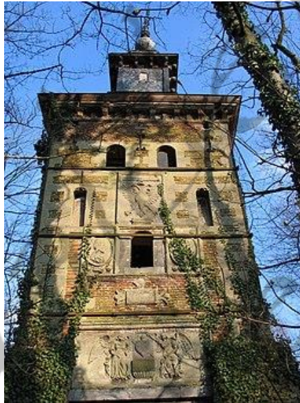
De enige nog overblijvende toren van het Bethaniakasteel
